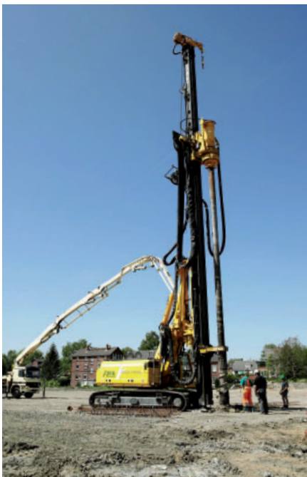
FDP – Pfahlherstellung mit RG 20 S FDP piling with RG 20 S
