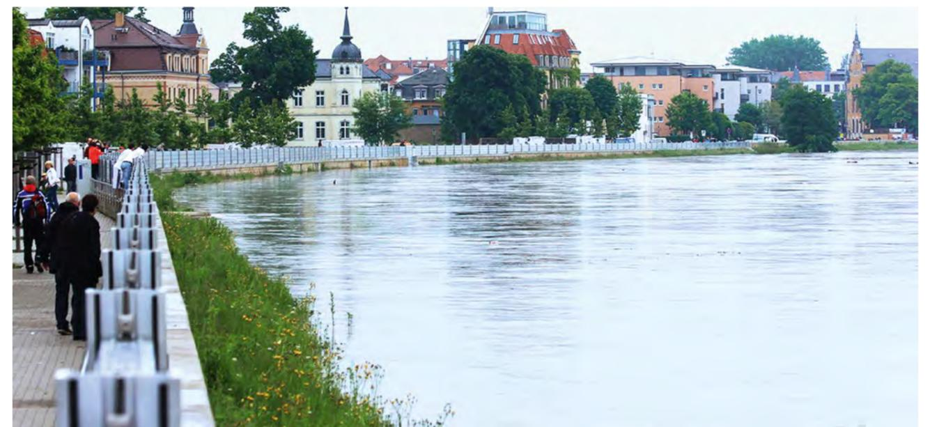
Es besteht aus nur wenigen Aluminium-Elementen, die in verschiedenen Schutzhöhen montiert werden können. Das terra Dammbalkensystem ist durch den Europaverband Hochwasserschutz e.V. geprüft und hat sich wirtschaftlich und ökologisch bereits in vielen Einsätzen bewährt. Es basiert auf dem Baukastenprinzip und besteht aus folgenden Elementen: terra Dammbalken, Stützen mit oder ohne Rückabstützung, Spanneinrichtungen, Ankerplatten sowie Sohldichtung.
