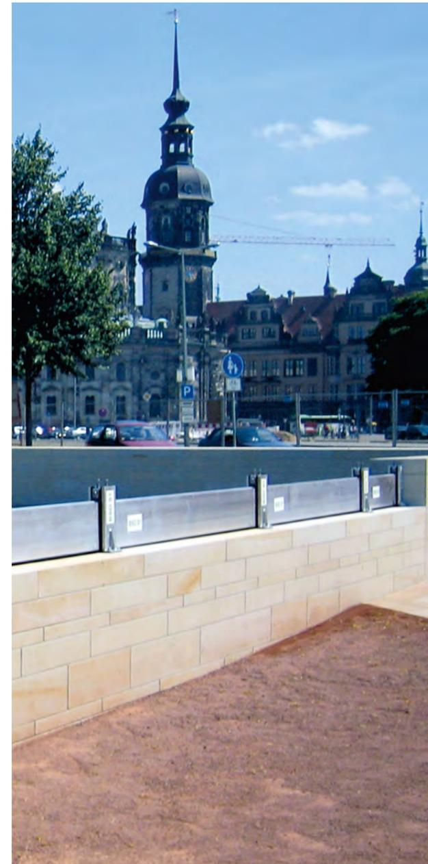
Le système de batardeaux terra a été testé par le TÜV et a déjà fait ses preuves sur le plan économique et écologique dans de nombreuses applications. Il est basé sur le principe modulaire et se compose des éléments suivants : batardeaux terra, poteaux avec ou sans appui arrière, dispositifs de serrage, plaques d'ancrage et joint de fond.
