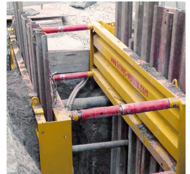
Le petit caisson en acier KVL est idéal pour les zones urbaines, le robuste KS 60 est recommandé pour les travaux de canalisation en ville et le KS 100 est utilisé à des profondeurs plus importantes.
